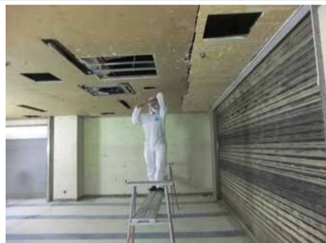
除去作業の様子
